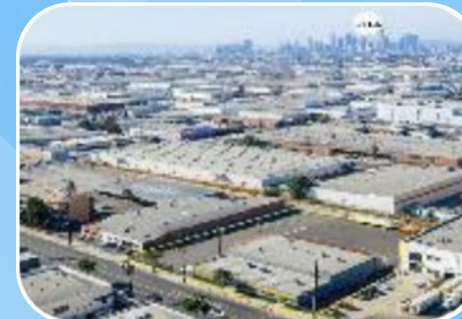
Instalaciones industriales, incluidas las estaciones de transferencia de residuos
